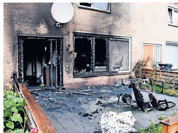
Voor de zwartgeblakerde woning zijn de restanten van de scootmobiel nog zichtbaar. FOTO HV ZEELAND
